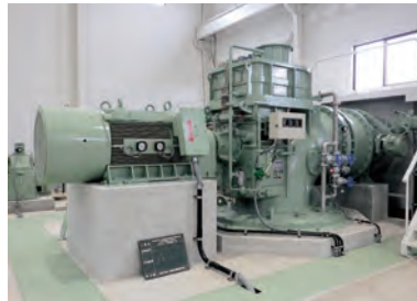
改修したポンプ設備 (須坂市)
