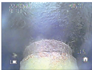
老朽化により錆びて更新時期を迎えている揚水ポンプ
