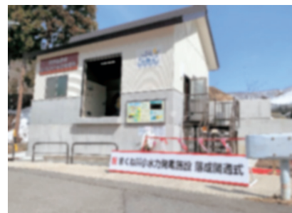
用水路の高低差を利用した野沢温泉村の小水力発電施設
