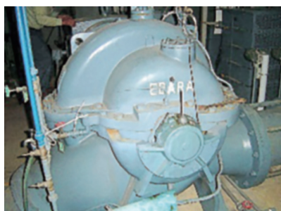
老朽化により錆びて更新時期を迎えている揚水ポンプ
