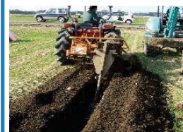
暗渠排水の整備
