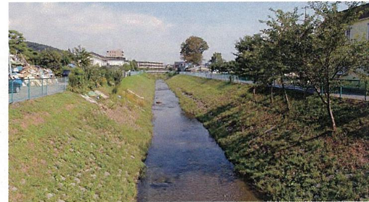
写真3 緩傾斜護岸。河床幅が狭いので、瀬や淵、砂州、流路の蛇行など川自身の働きによる微地形の形成は期待できない。
