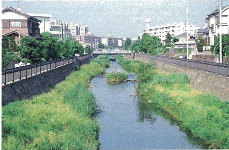
写真3 ヤシ繊維工法を用いた修復（施工後約半年、1994）。水際部にヤシ繊維ロールを設置しヨシやガマを植え付けた。
