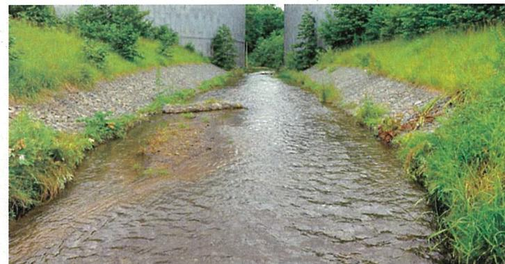
写真10 オボップ川（北海道） 設置後1年（2007.6） 土砂が堆積しつつある。
