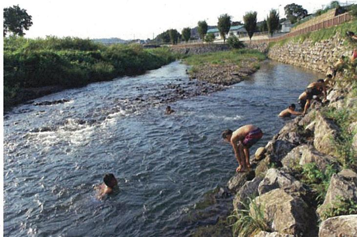
写真9 平井川（東京都） 根固め工を深い位置に設置し淵を保全した。
