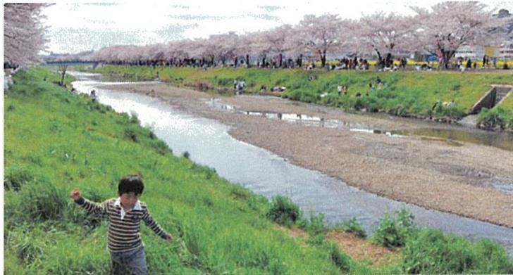
写真5 黒目川(写真4の直上流) 単断面区間。河床幅を広く確保しているため、川の働きによって複雑な地形が出現している。
