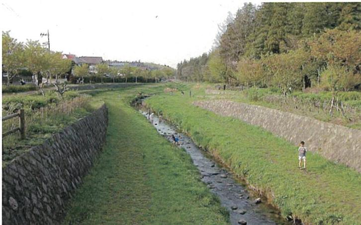
写真2 after 流路の平面線形は隣接する斜面林の等高線をトレース
