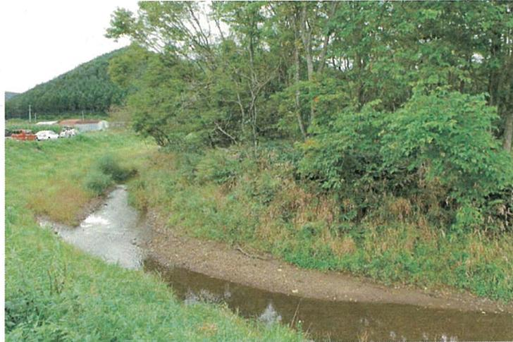
写真7 土谷川(岩手県葛巻町) 既存の河畔林を残すために片側を拡幅した。
