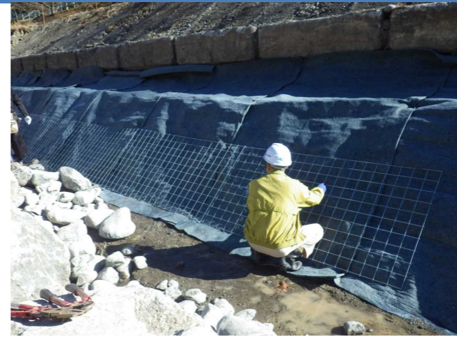
③ 背面ネットの設置を行います。
