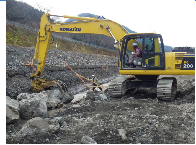
④ 根石の据付を行います。
