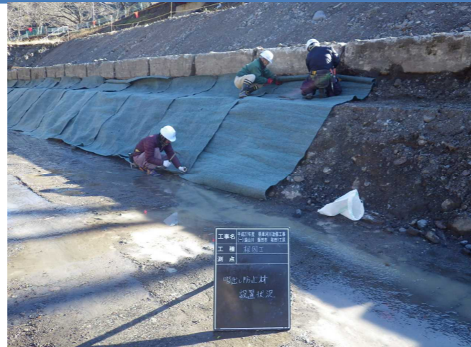
② 吸出し防止材を設置します。
