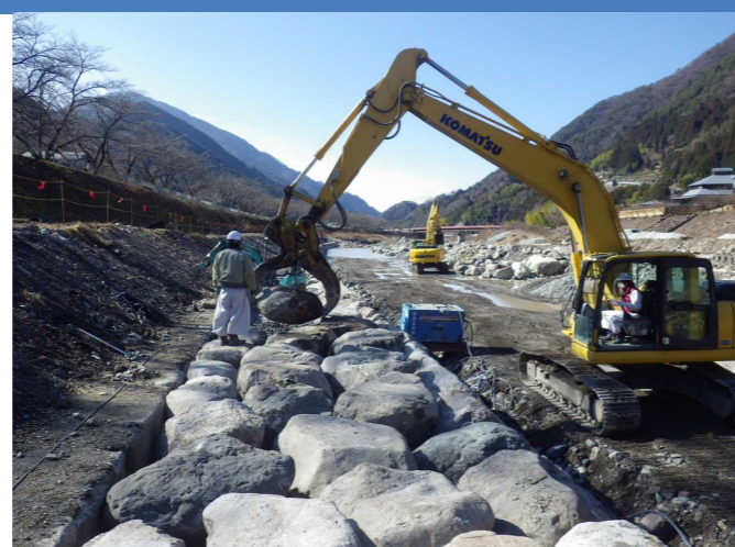
⑥ 天端に巨石を据付けます。
