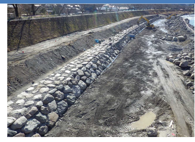
⑫ 天端に胴込材を投入し完了となります。
