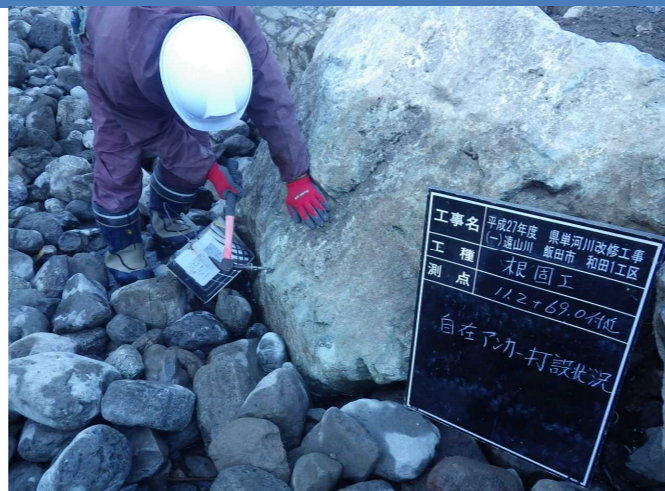
⑥ 自在アンカーを打設致します。
