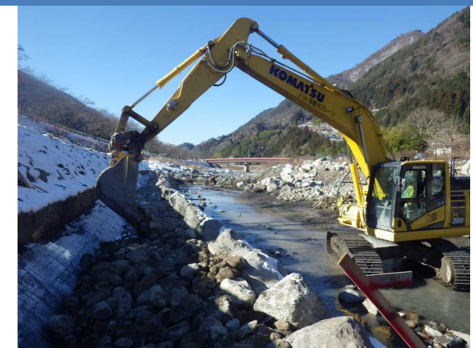
④ 胴込材を投入し、巨石の下地を作ります。
