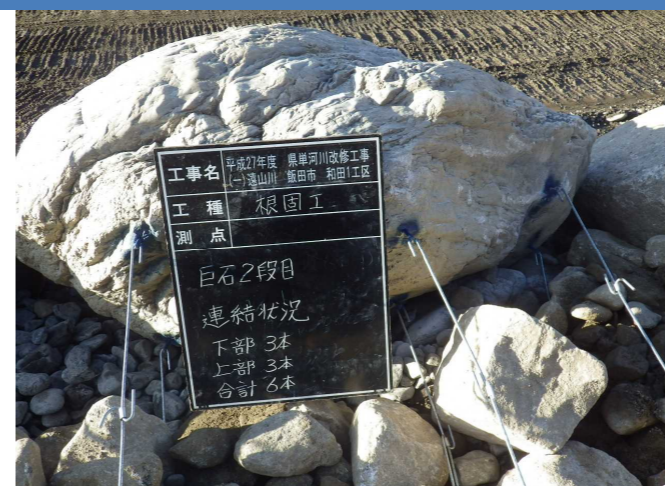
⑪ 2段め巨石設置完了下部3本、上部3本 計6本
