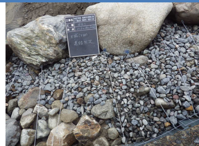
③ アンカーシャフトにて連結を行います。
