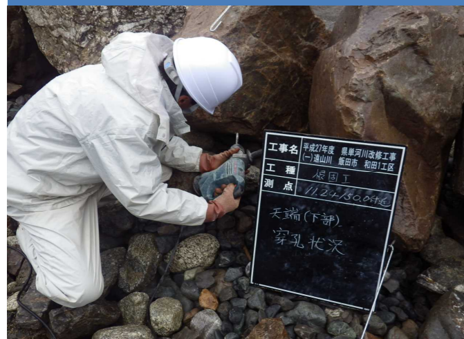
① 天端石の下部に穿孔を行います。
