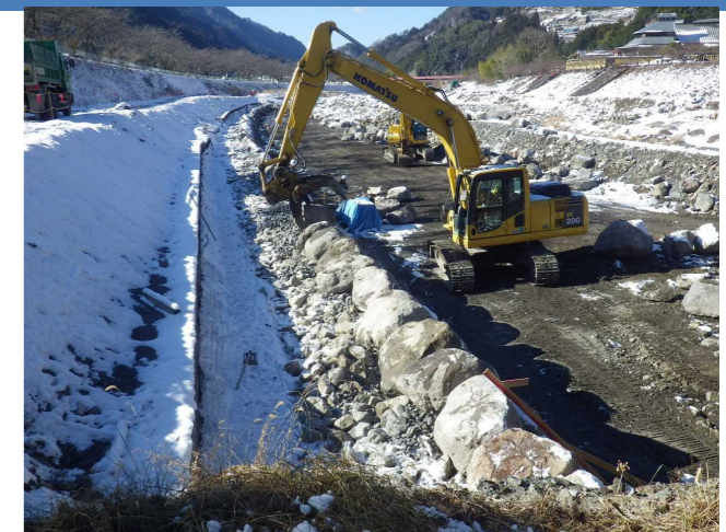
⑫ 天端の巨石の据付を行います。
