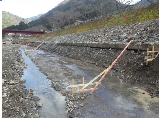
① 床堀並びに法面整形完了。
