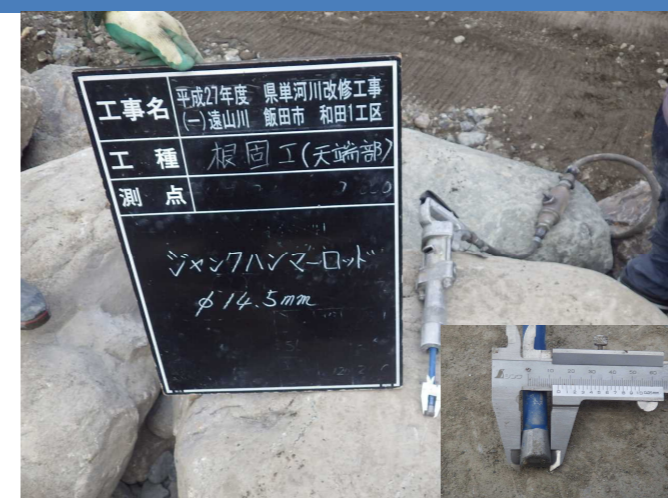
⑦ 穿孔に使用するジャンクハンマーのロッドは、径14.5mmで穿孔致します。
