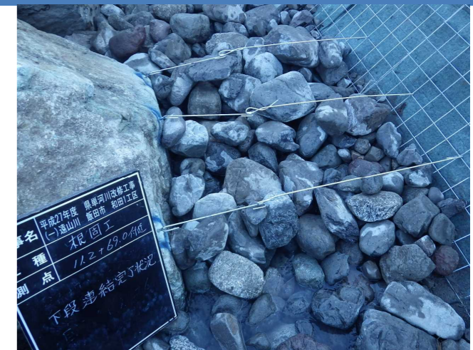
⑧ アンカーとシャフトによって背面金網と連結します。
