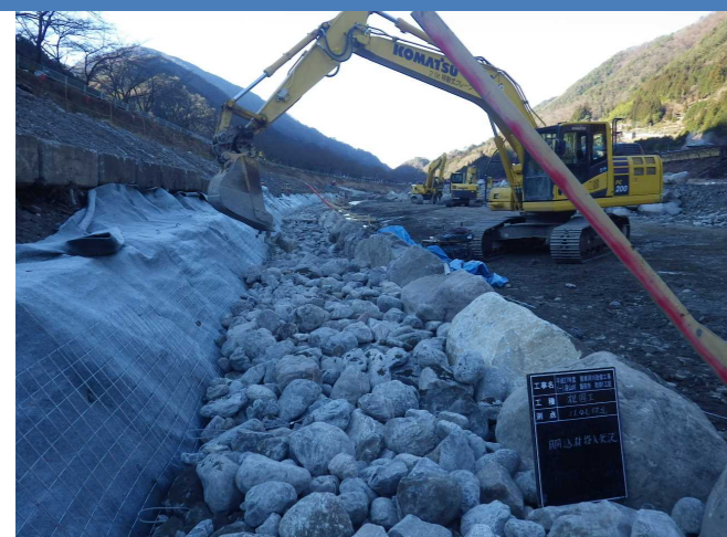
⑨ 胴込材の投入。充填状況。
