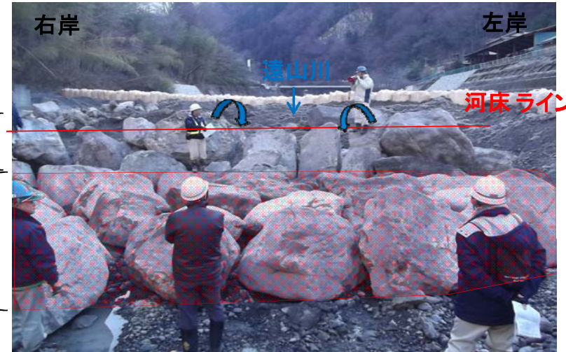
説明状況(帯工+床張工)
