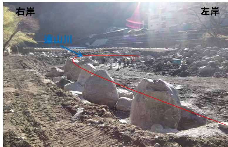
帯工形状(右岸側の半分) 下流より撮影
