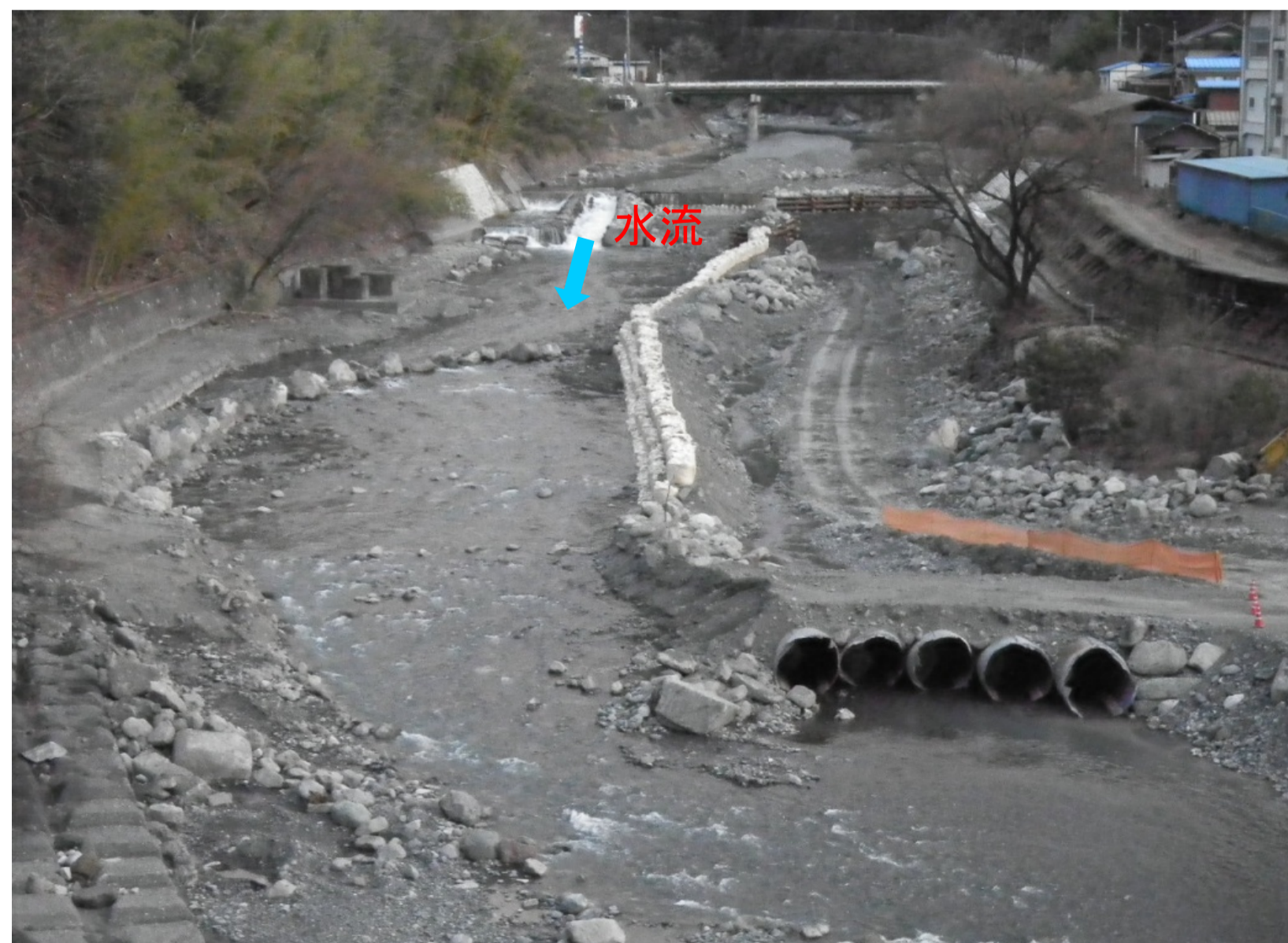
二次仮締切り完了 (下流より撮影)
