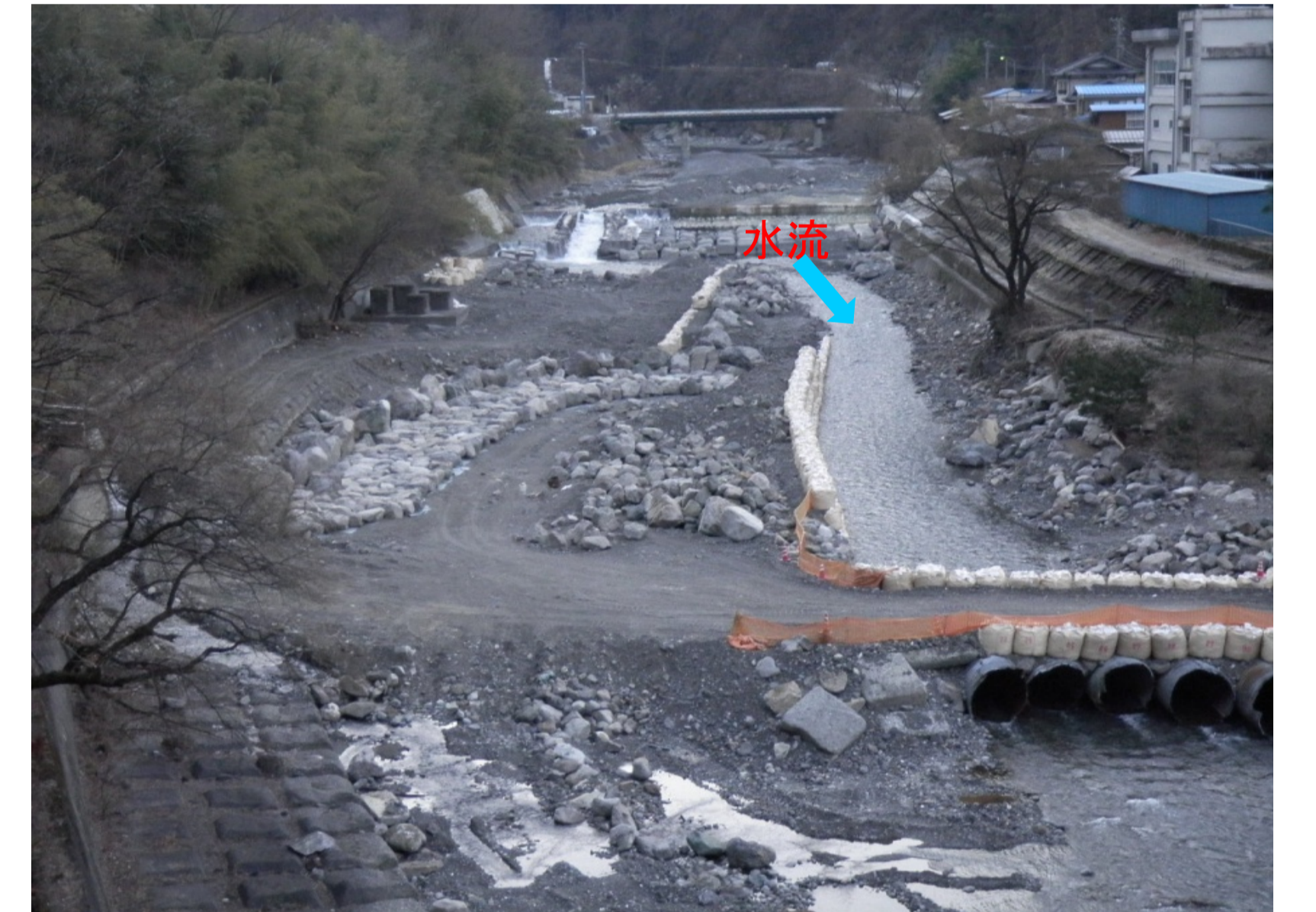
一次仮締切り切替え前 (下流より撮影)
