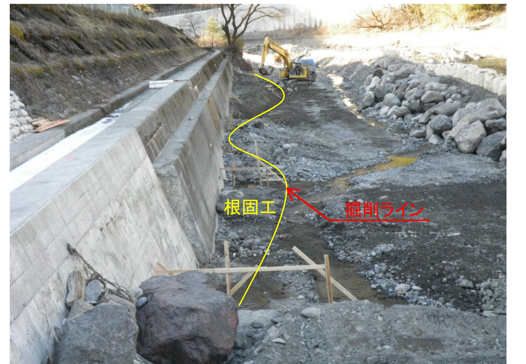
左岸側根固工掘削作業状況 (上流より撮影)
