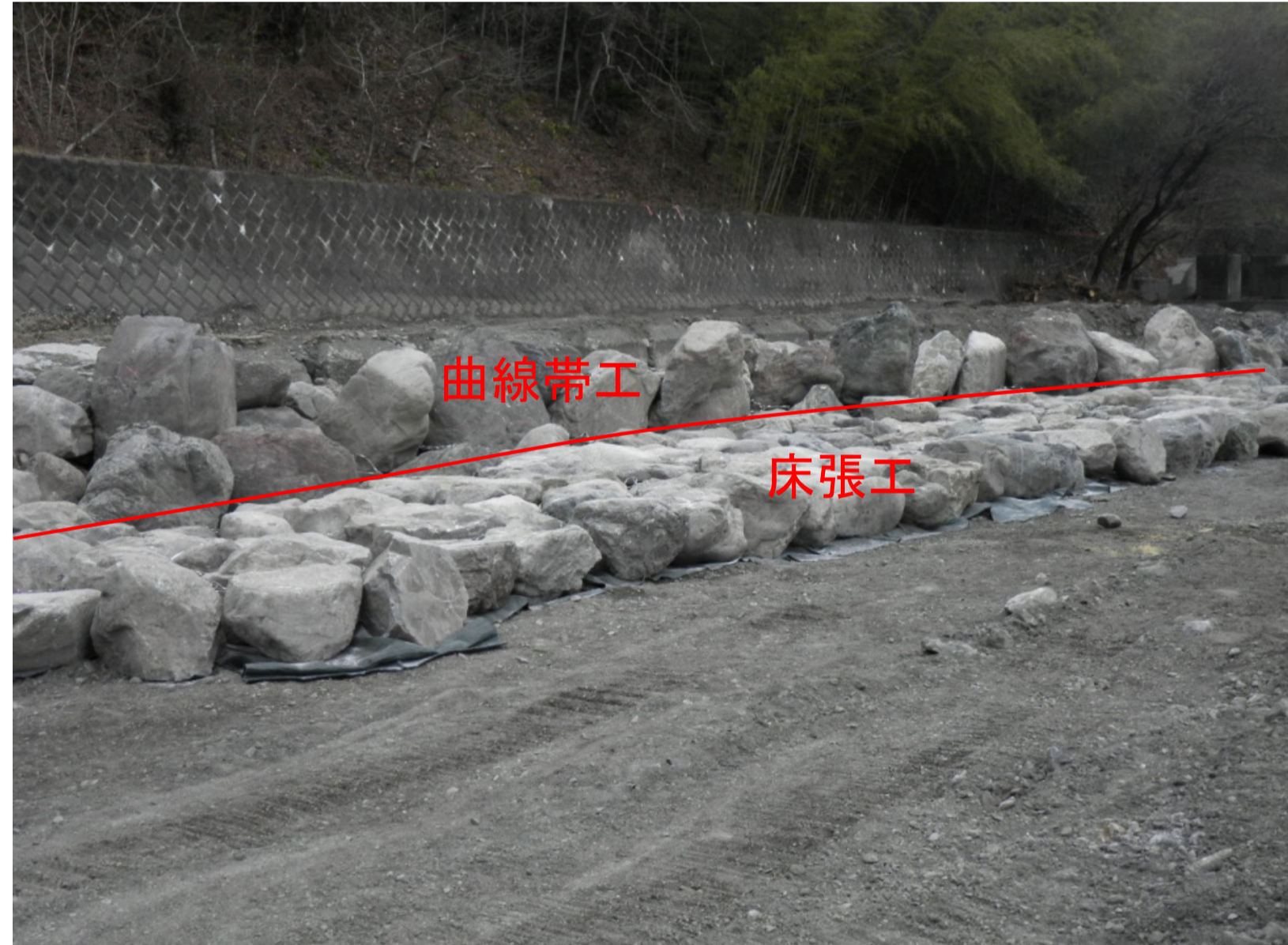
曲線帯工+床張工完成(右岸側半分)
