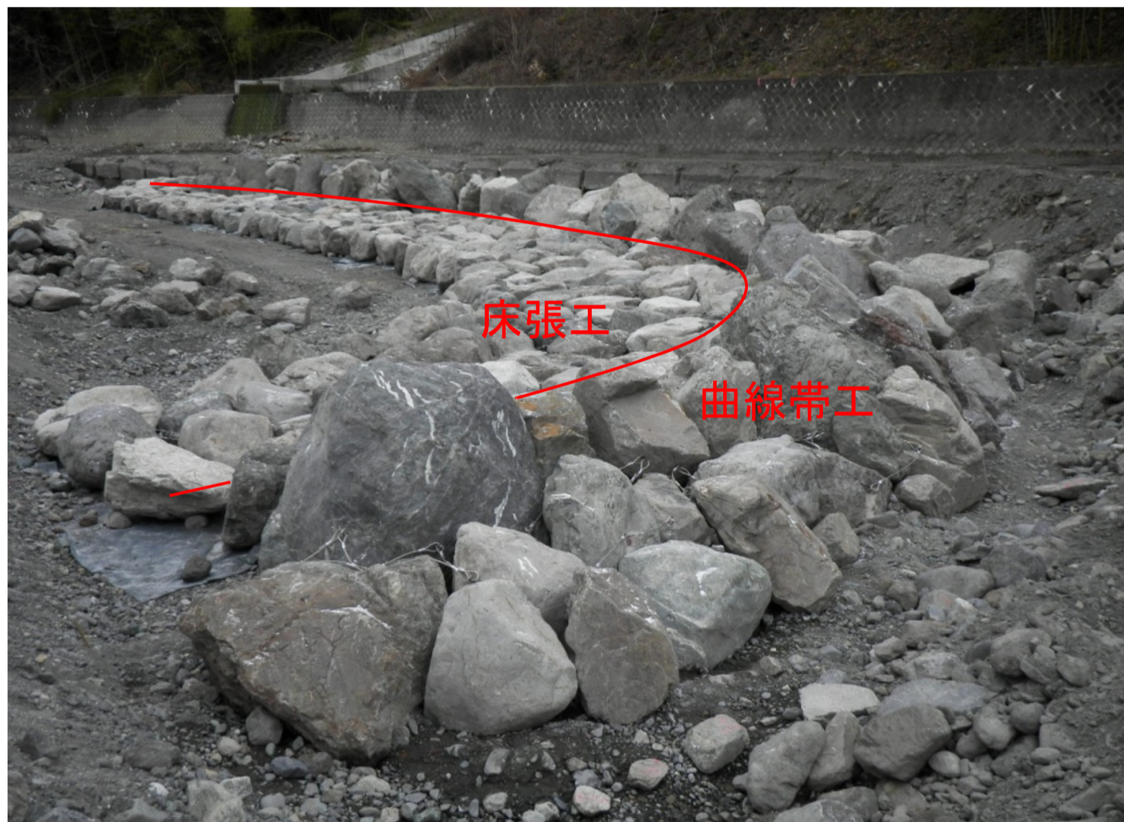
曲線帯工と床張工完成(右岸側半分)
