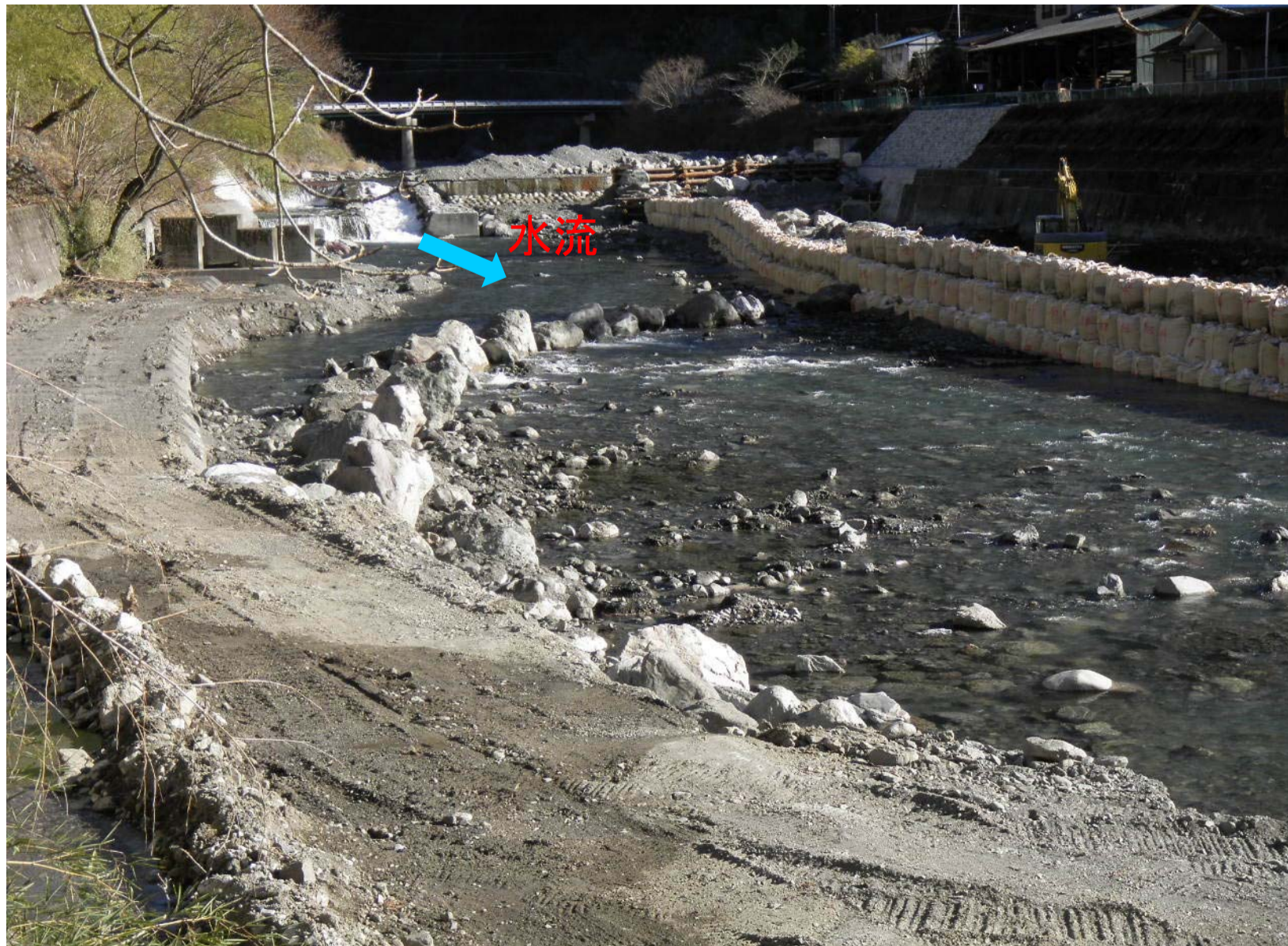
瀬替え後の曲線帯工+床張工の様子 (下流より撮影)
