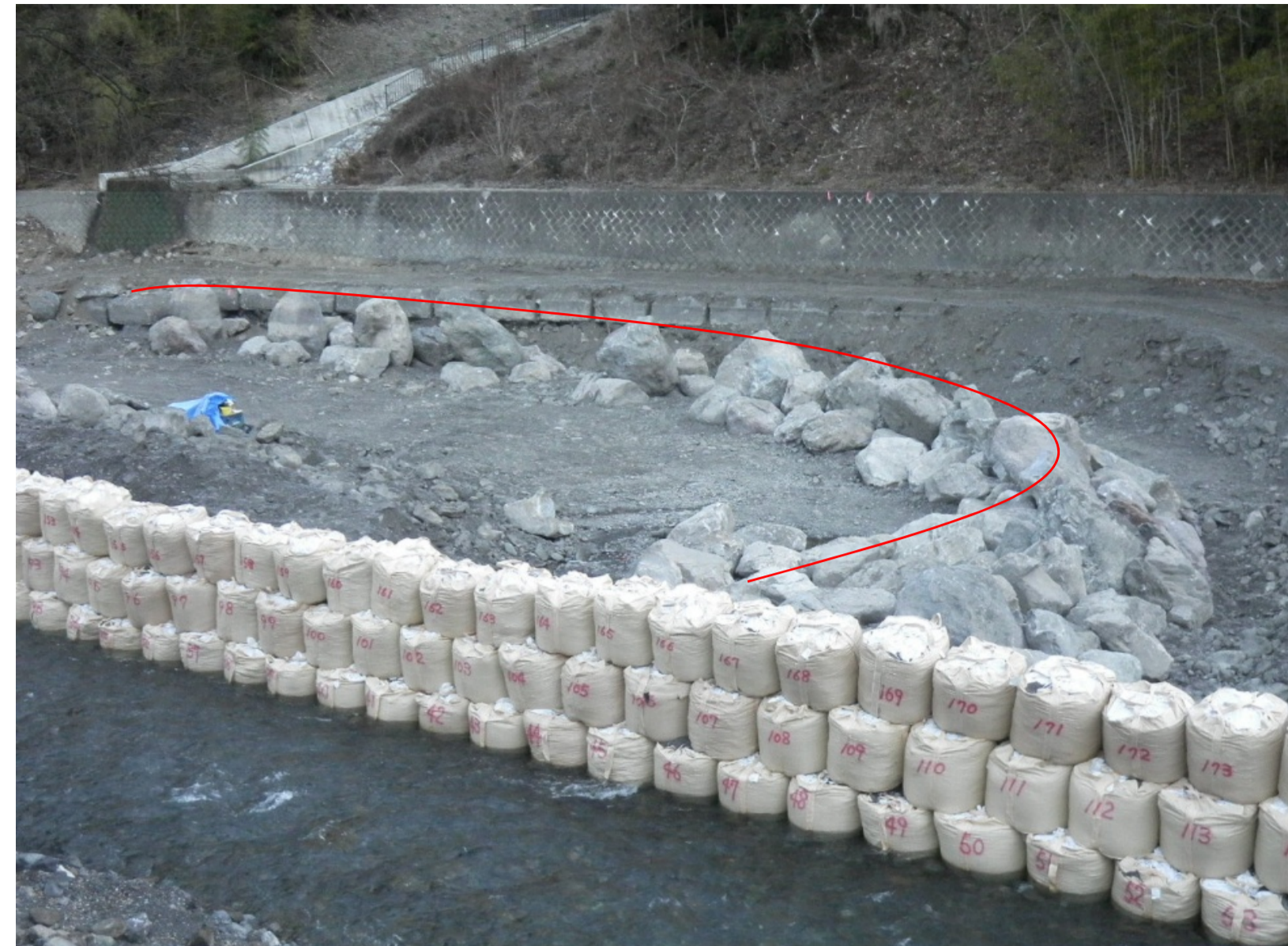
曲線帯工形状(右岸側) 上流より撮影
