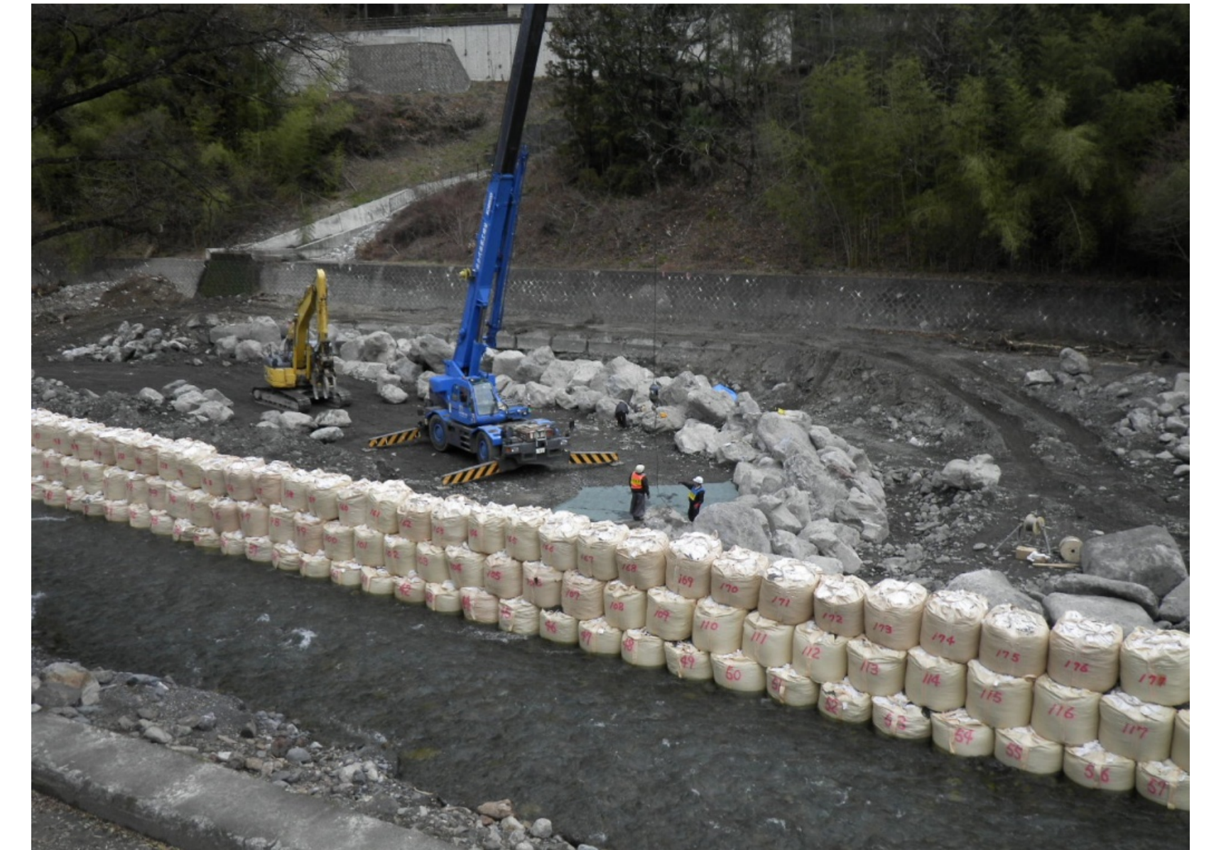
床張工(右岸側)石材据付け作業状況
