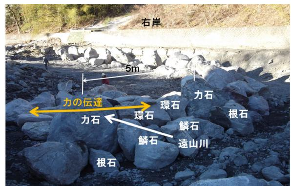
図-19 石据付状況 右岸側帯工
