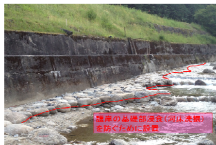
写真-2 根固め工イメージ
