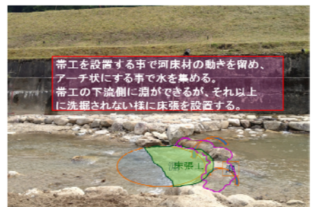
写真-3 曲線帯工イメージ
