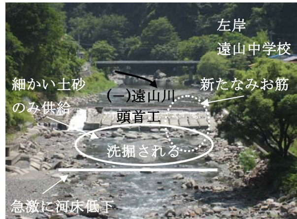
写真-1 遠山中学校横工区 現況
