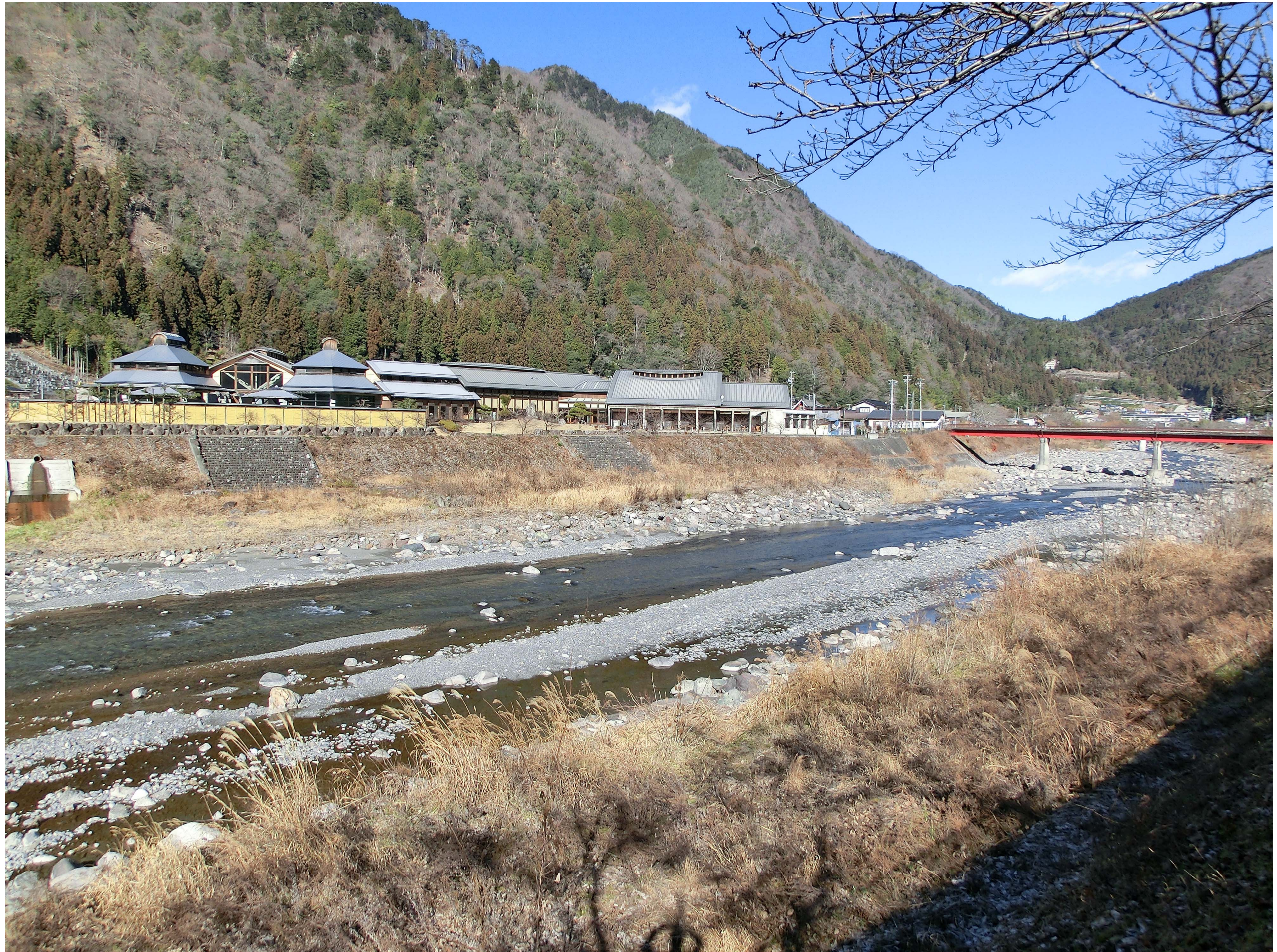
中橋下流 現在の状況
