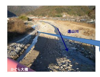
河川の水を左岸側へ 流し、右岸側を施工 しています!
