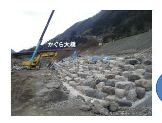
クレーンで巨石を 吊った状態で 据え付ける方向を 確認しています!
