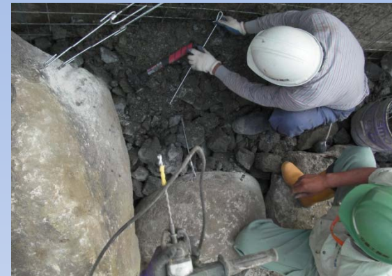
③石材へ穿孔アンカー打込
