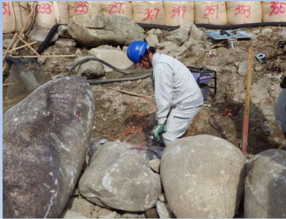
⑦アンカー固定のため石材に穿孔
