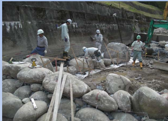
②根石据付け
