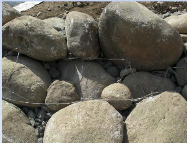
⑨隣接石材をワイヤーで上下左右連結
