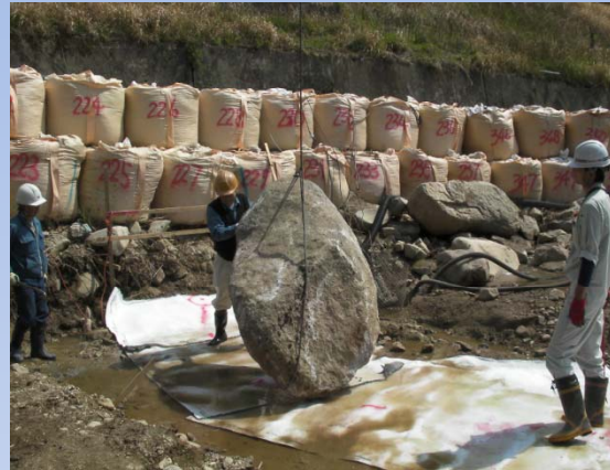
②力石据付け
