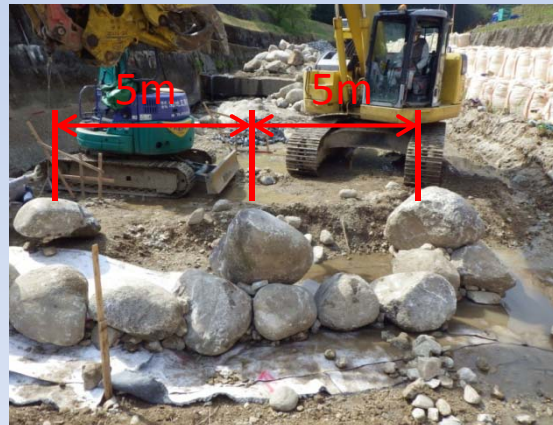
⑤力石と力石の間は環石で埋める
