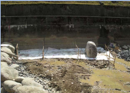
①床付後吸出防止材設置
