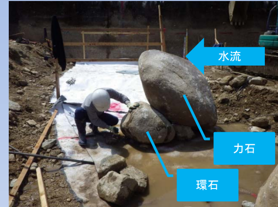
③力石は下流側へ傾ける
