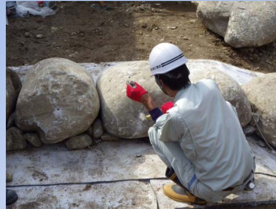
⑧穿孔箇所にアンカー打込み
