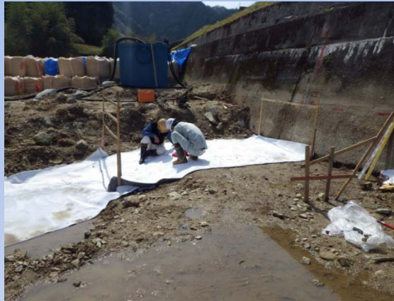
①床付後吸出防止材設置
