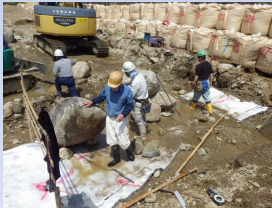
④力石の間隔は5m程度
