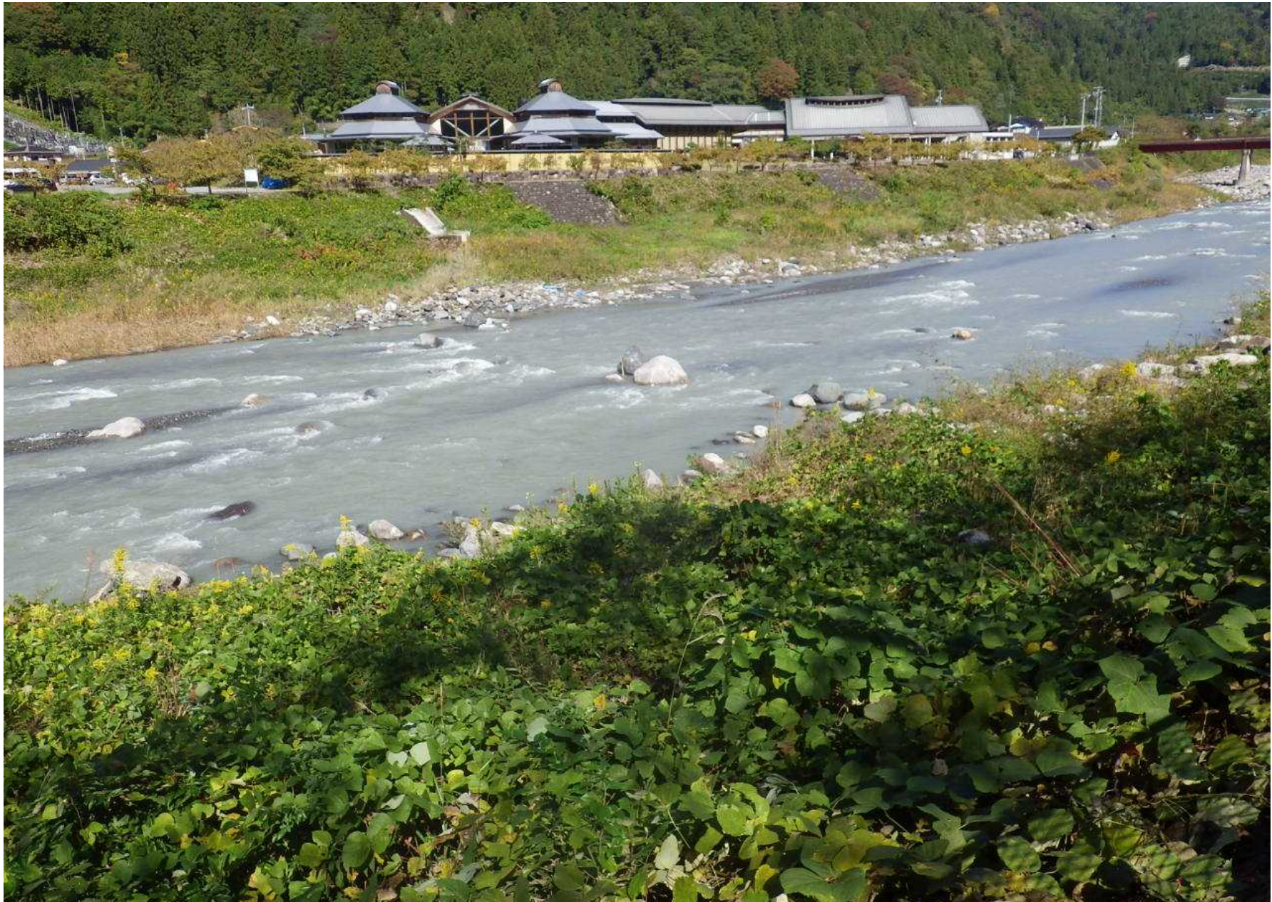
かぐらの湯横 着手前(平成26年10月)
