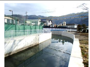
【幹線排水路の改修】
