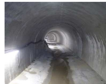
水路トンネルの更新
