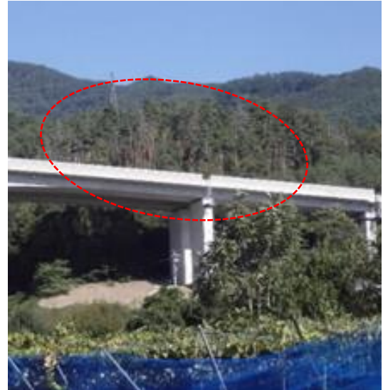
利用した上信越自動車道脇の枯損木(坂城町)
