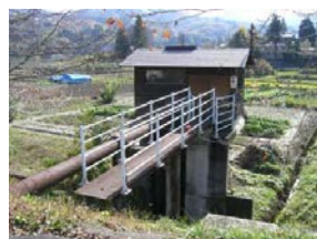
犀川沿岸で湛水被害が生じているため、排水機場の整備を行いました。
