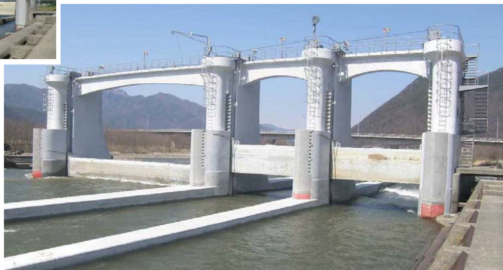
補修工事竣工後
