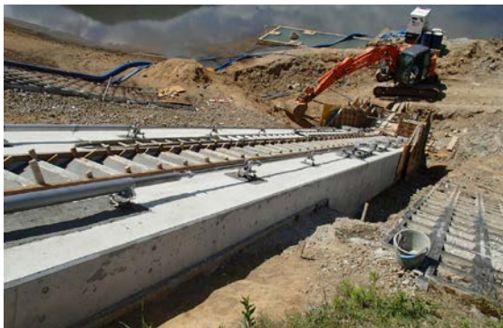
取水施設(斜樋)の改修(施工中)
