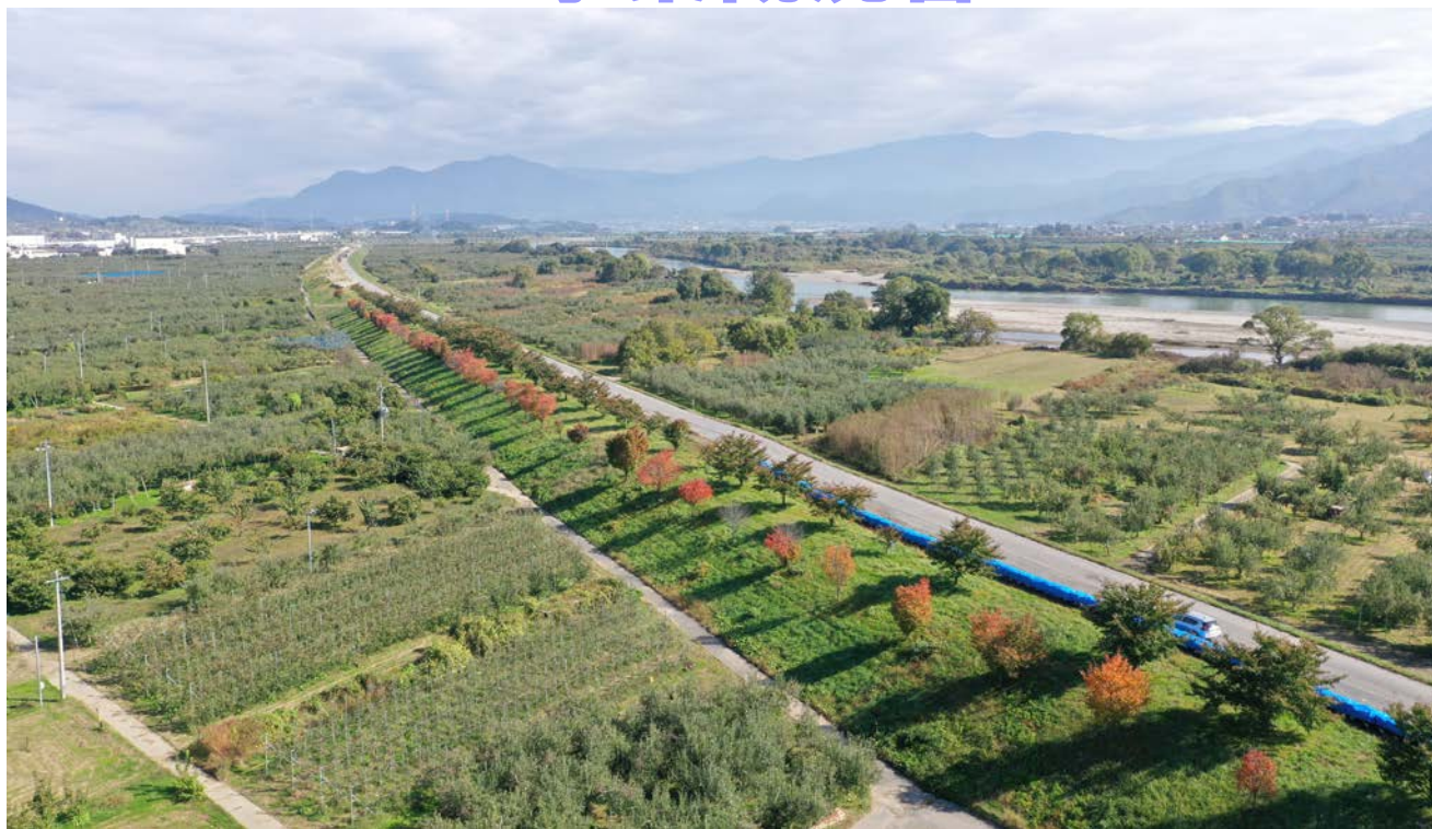
～災害から1年～ 令和元年台風19号豪雨による千曲川堤防決壊箇所（令和2年10月撮影）
