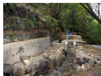
石津水路の取水口改修
