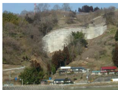
▼対策後 (平成 24 年)
