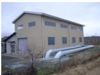
改修された建屋
