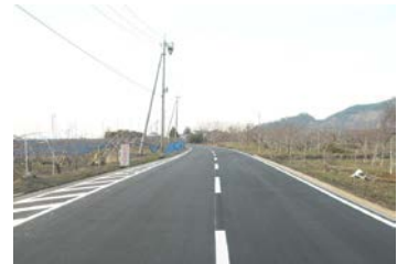
舗装実施区間
