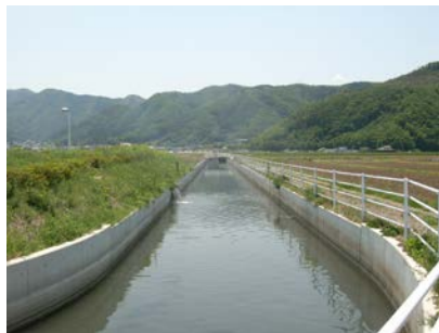
排水路の完成区間
