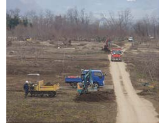
排土工事実施状況（長野市）
