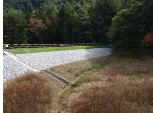
自然石による波除護岸を施工
