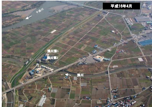
令和元年台風19号発生前の千曲川沿岸の様子（航空写真）
