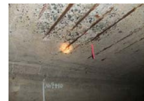
頂版鉄筋露出・コンクリート剥離
