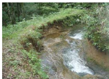
山腹水路で法面が洗掘され、不安定な状態となり、今後下流農地や家屋へ甚大な被害発生のおそれがあります。
