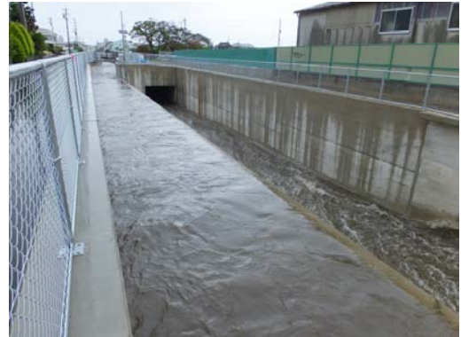
完成した分水工 (整備後)
