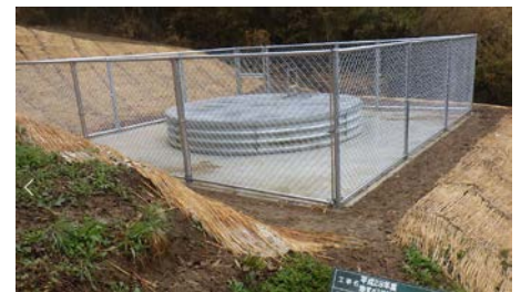
▲対策後 集水井 (上河地区) (平成 29 年)
