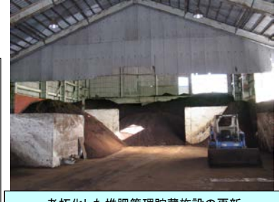
老朽化した堆肥管理貯蔵施設の更新
