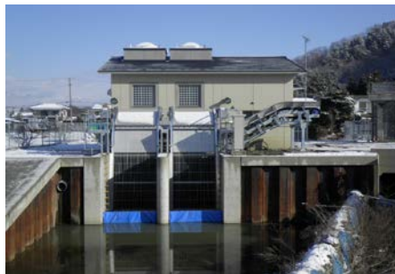
施工中の大堰排水機場
