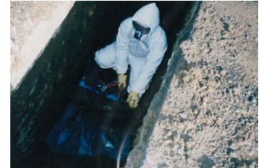
石綿管撤去の様子
