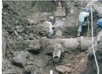
石綿管布設状況
