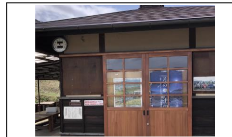
【姨捨の棚田姪石苑土間改修】
