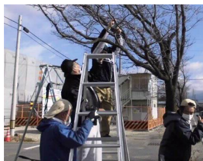
【イルミネーション設置作業】
