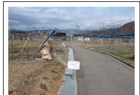
【水路改修事業】
