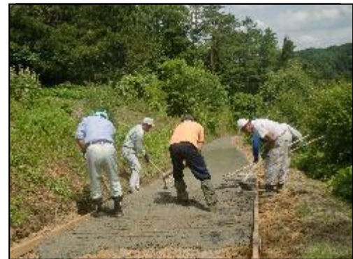
【小根山町地区 (細越) での作業】
