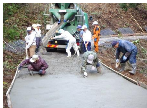
【舗装工事風景】
