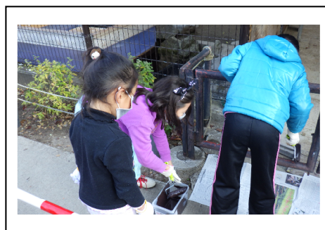
【立入り防護柵の補修協働事業】
