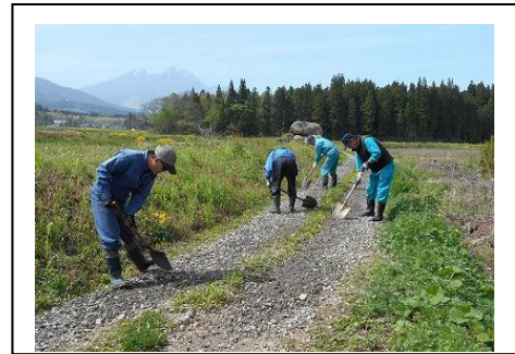
【砕石敷均作業 (仁之倉区)】
