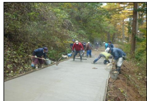
【舗装工事風景】
