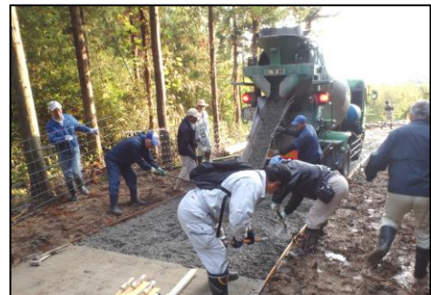
【舗装工事風景】
