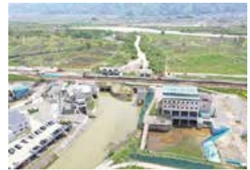
浅川排水機場
