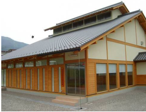
全景：木造の図書館に隣接し木の香る重厚な木造施設
