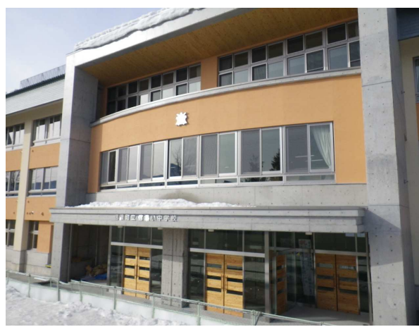
校舎昇降口外観
