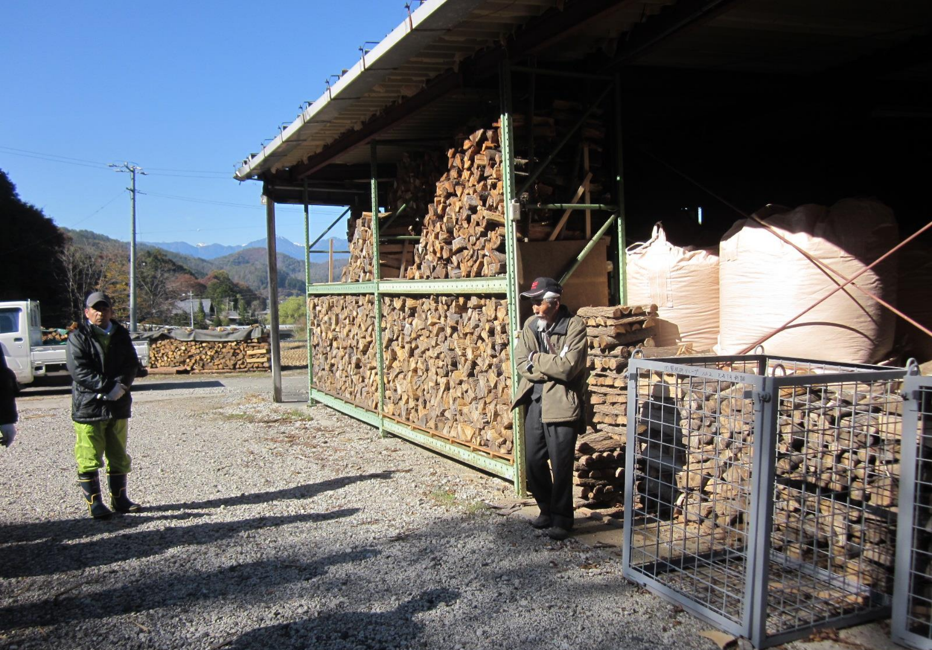
完成した 薪ステーション 四賀の里 錦織(にしごり)
