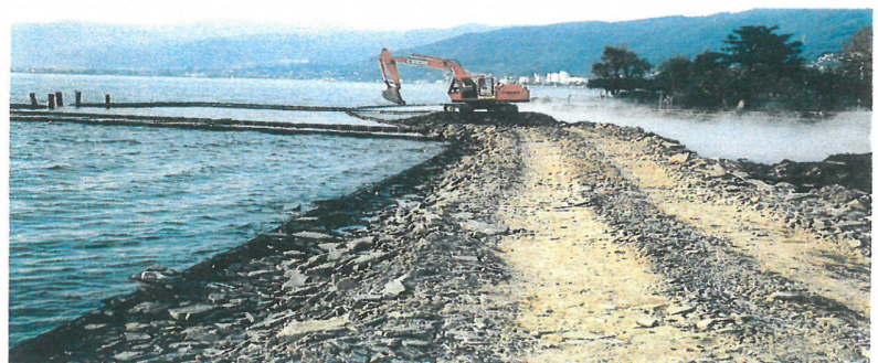
写真4-21 鉄平石を用いた盛土
