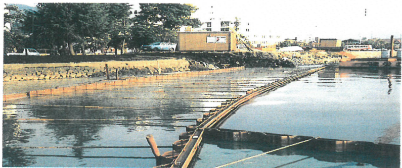
写真4-19 鋼矢板工
