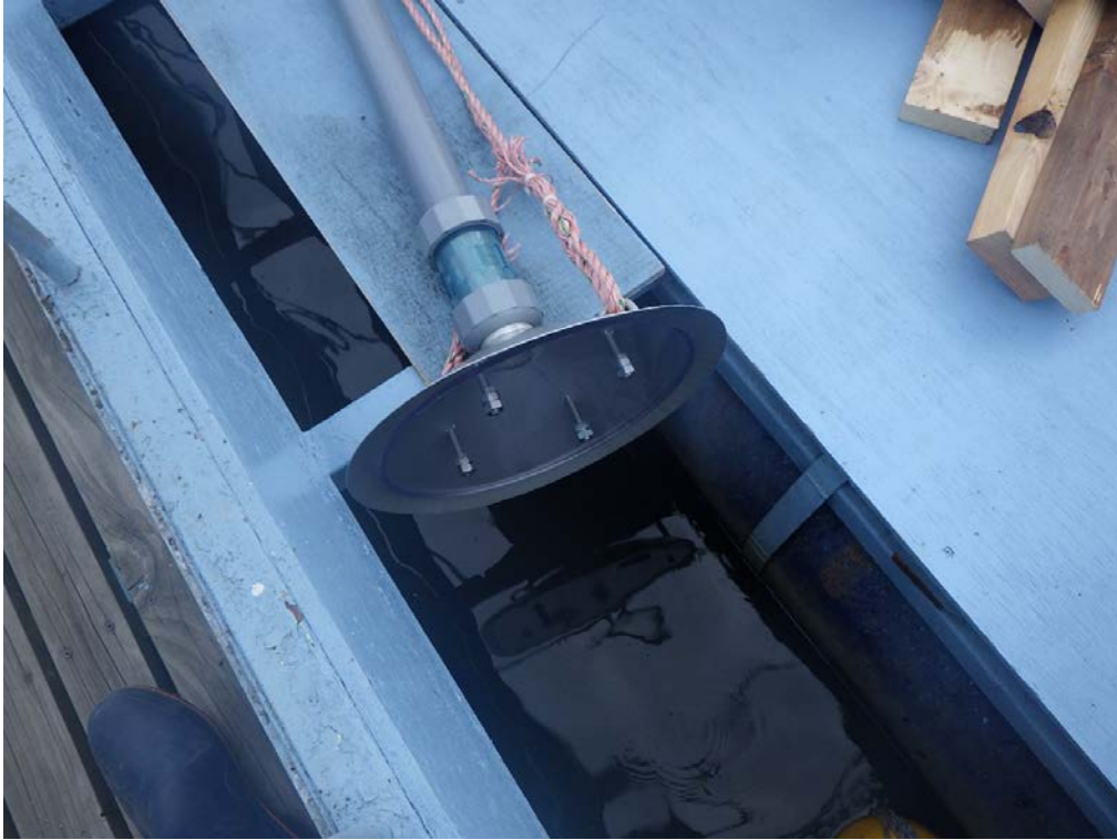
写真4 散気ノズルの外観
