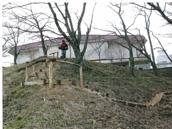
【群生地整備 遊歩道設置】
