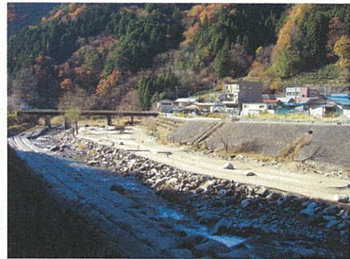
【完成したコース】
