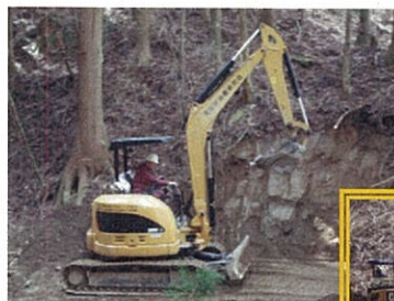
【作業道開設と 間伐材搬出状況】
