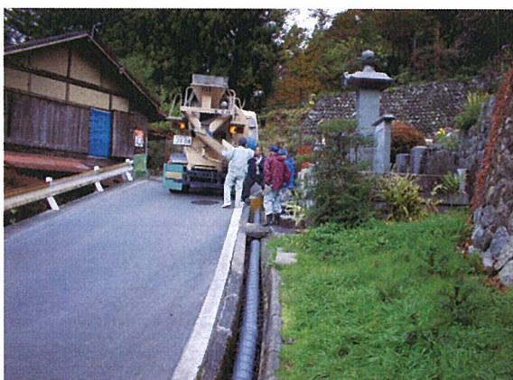
【東原B区 村道長野原線間詰舗装】
