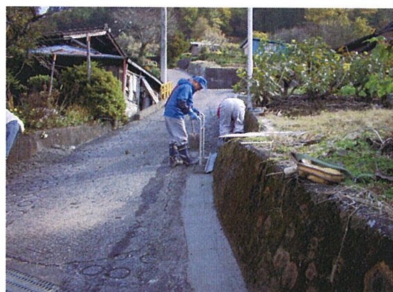
【東原B区 村道原新田線間詰舗装】
