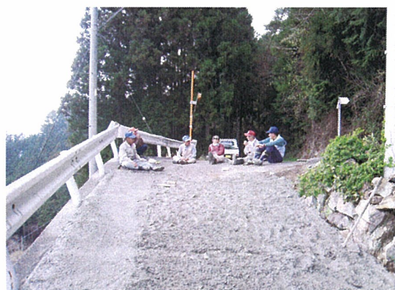
【途中上平区 村道途中線路面舗装】
