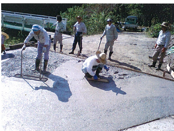
【中組区 村道川合線路面舗装】
