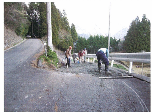
【途中上平地区の道路面修繕】
