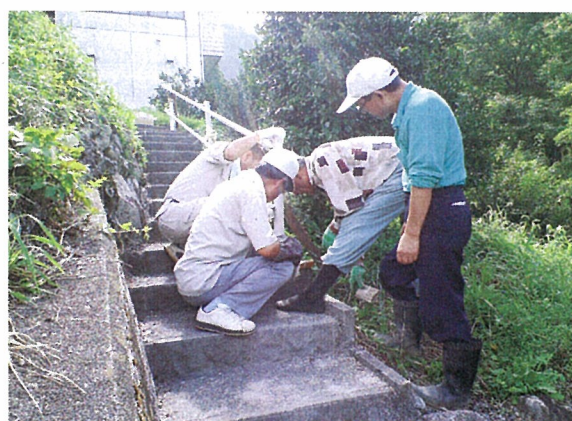
【中央区 村道本町中央線手すり設置】
