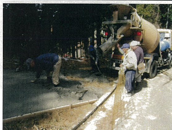
【向方・峠山区の路面舗装】
