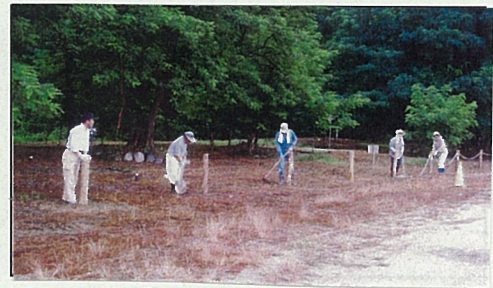
【境界杭打込状況】
