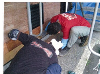
【間伐材を利用して腐食した板壁を整備】
