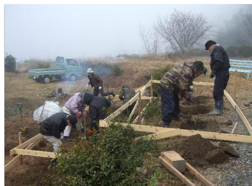
【休憩所基礎工事】
