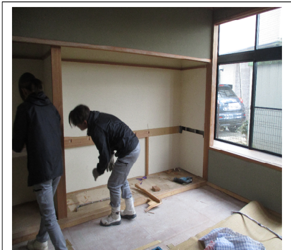
解体中の写真。押し入れを高齢者向けトイレにするため中段の敷居を取外し押し入れ中を空洞にした
