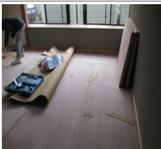
解体中の写真。床を「畳」「無垢材」「フローリング」「タイルカーペット」の4種類にするため畳を全て撤去した
