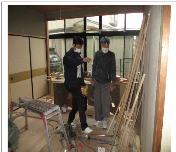
改装作業中の写真。福祉介護事業者の岡島さんの指示で建設業部会員が奉仕作業で室内を改装した
