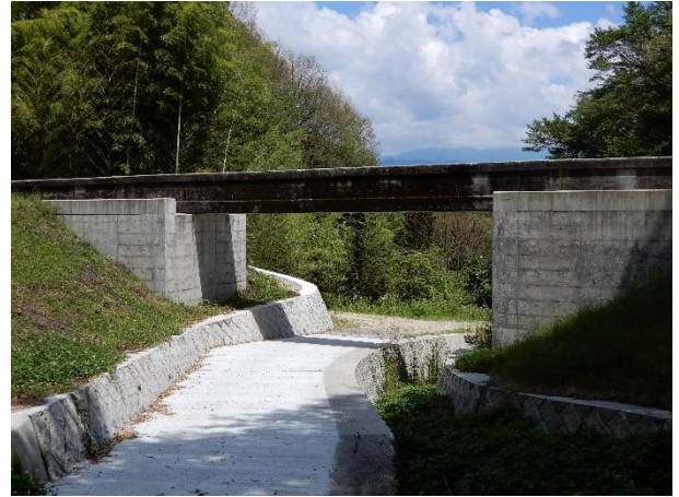
【水路橋の耐震補強（飯田市）】
