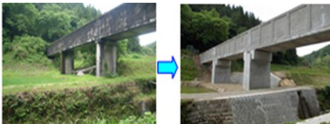
耐震補強が完了した胡麻目沢水路橋（竜西一貫水路）
