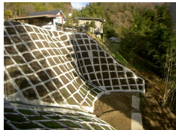
地すべりにより崩落した斜面へ対策工事を実施（阿南町）
