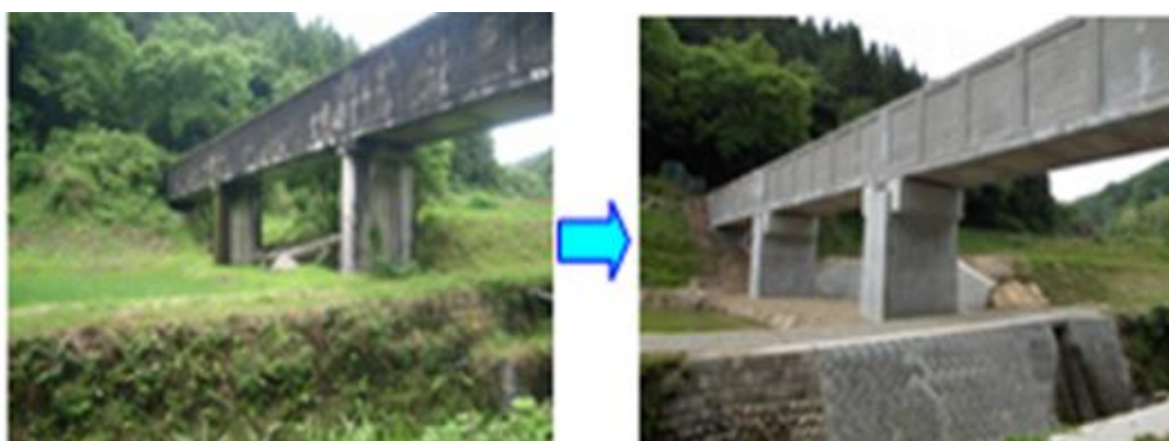
耐震補強が完了した胡麻目沢水路橋（竜西一貫水路）
