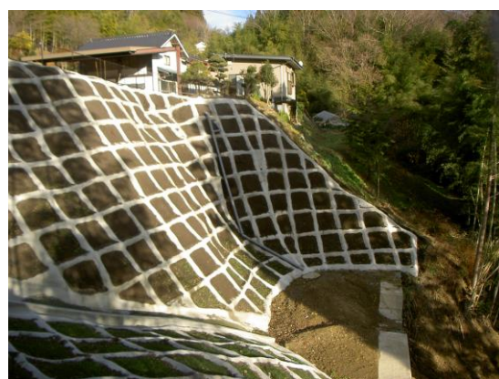
地すべりにより崩落した斜面へ対策工事を実施（阿南町）
