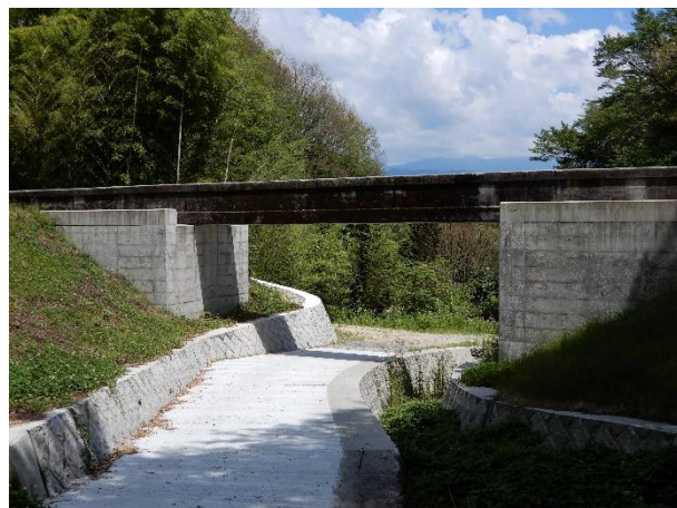
【水路橋の耐震補強（飯田市）】
