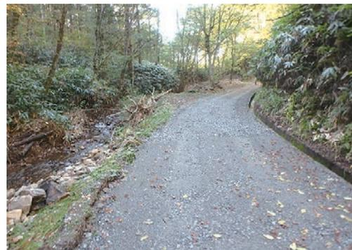
溪流の排土及び路面への埋戻しにより復旧した。
