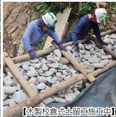
【木製校倉式土留工施工中】
