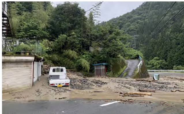
飯田市上村万場地区土砂流出状況
