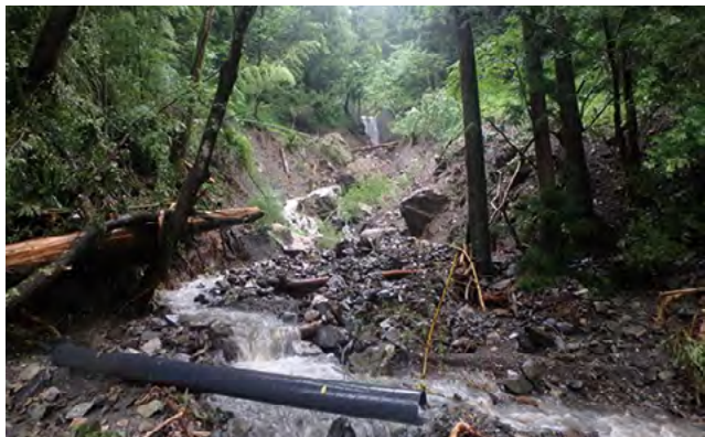
飯田市上村万場地区上流状況（谷止工計画箇所）
