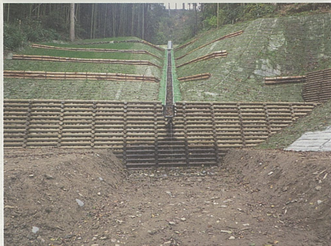
下伊那郡 喬木村 伊久間（土留工）
