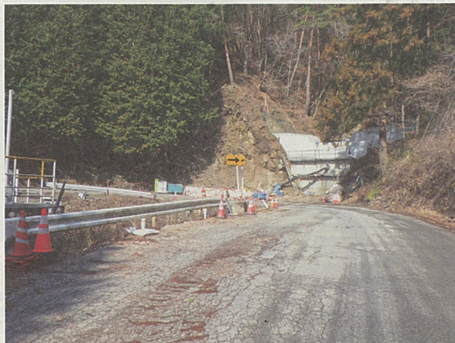
土砂流出対策：谷止工（施工中）
