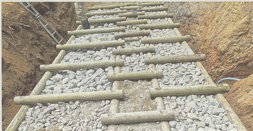
木製校倉式床固工 内部
