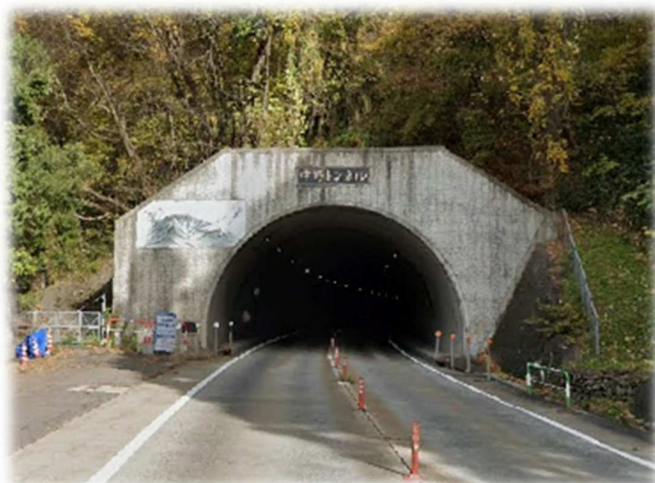
中野トンネル
