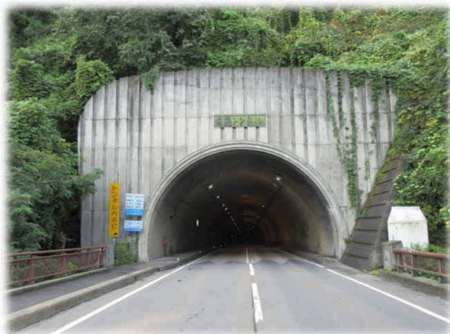
日高トンネル
