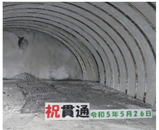
(仮称)青崩峠トンネル工事中
