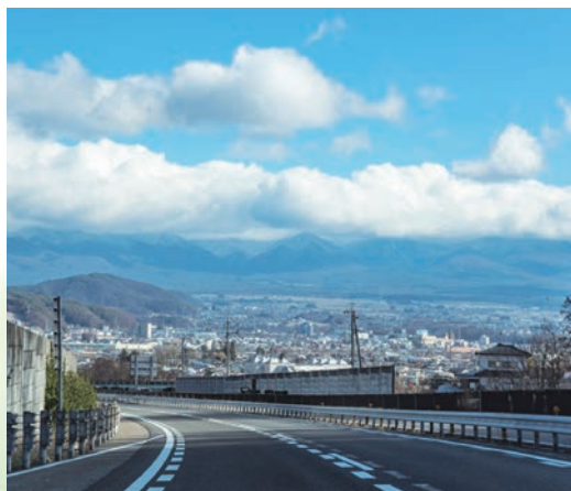
諏訪IC付近から八ヶ岳方面を望む
