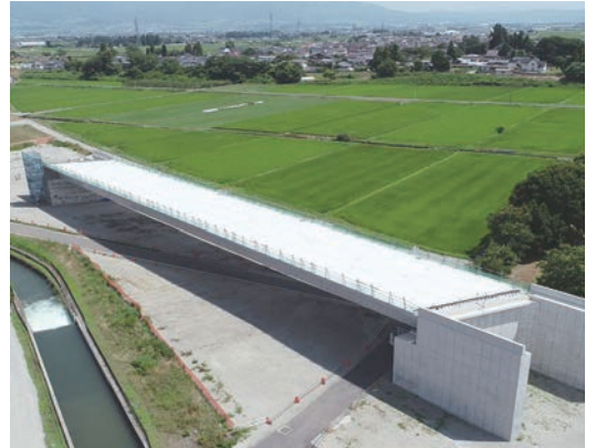
扇子田公園付近橋梁工事中
