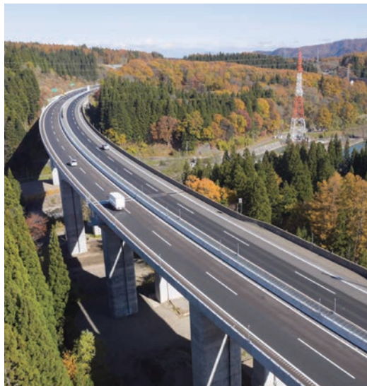
新潟県境の「れいめい橋」
