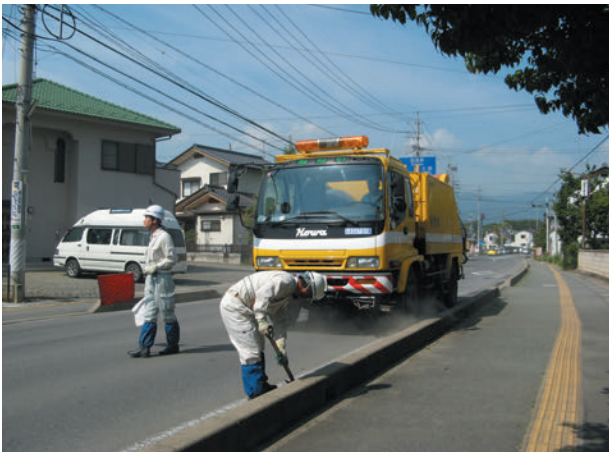
〔路面清掃状況〕
