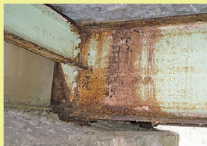
橋桁の腐食
