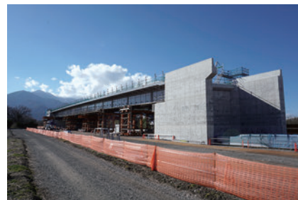
扇子田公園付近橋梁工事写真
