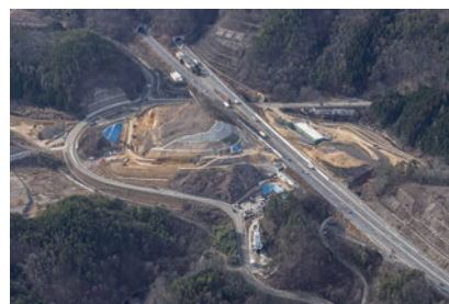
令和 5 年内の工事完了に向けて、整備が進められています。
