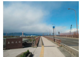
五輪大橋有料道路
