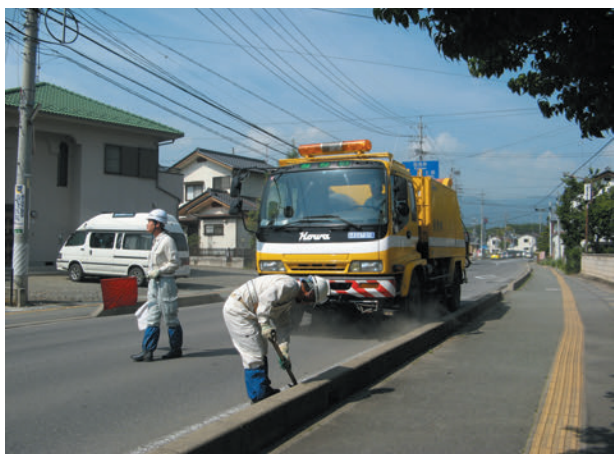
〔路面清掃状況〕
