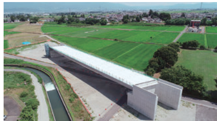
扇子田公園付近橋梁工事写真
