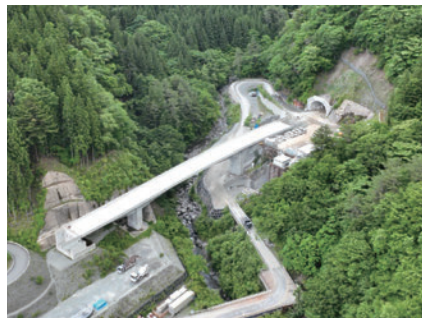
（仮称）青崩峠トンネル工事写真
